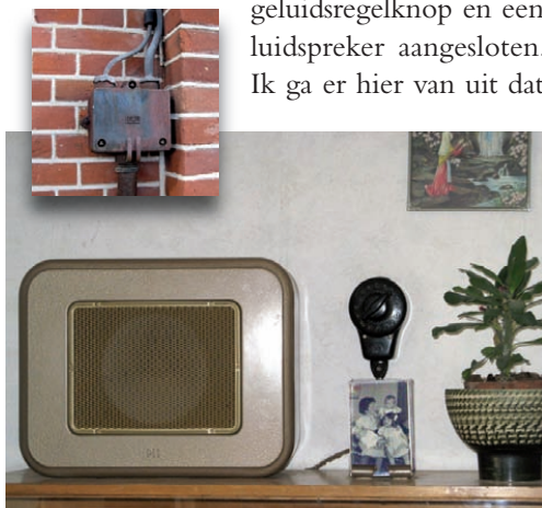
Het buitenkastje, de luidspreker en de schakelaar.
