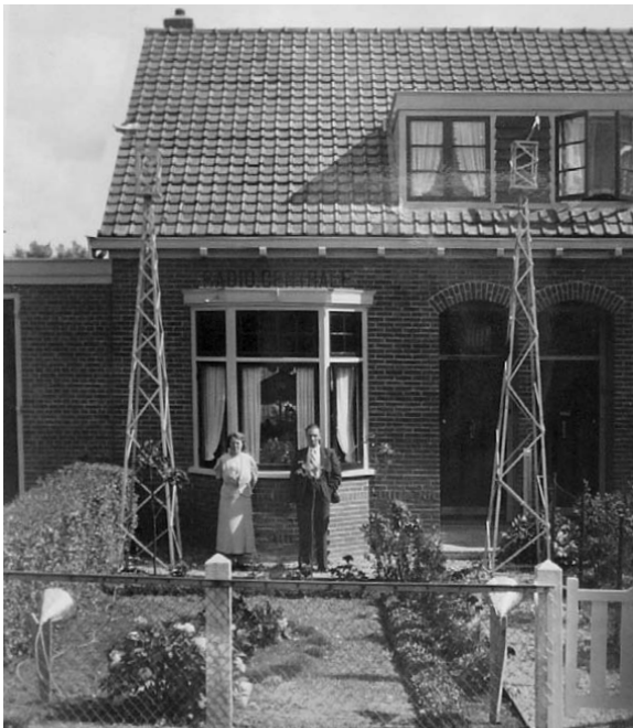
De zendmasten zijn geplaatst.
