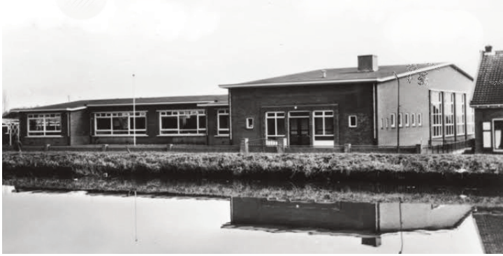
Warinschool Gymlokaal 1980, gesloopt voor de Blijklaan. (toegang nieuwe Sporthal)
