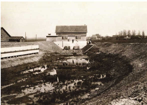
Driemaal is scheepsrecht. Dit derde gemaal uit 1926 voert het water van de Horstermeer naar de Vecht af door het boezemkanaal dat door de Meer- uiterdijksepolder heen is gegraven.
