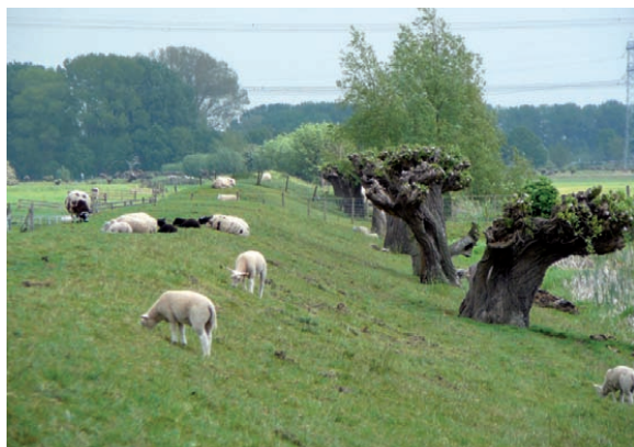
De Liniedijk in de richting van Fort bij Nigtevecht. Deze dijk moest het water dat bij inundatie uit het zuiden kwam tegenhouden.
