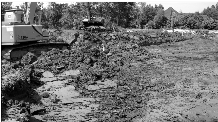
Afb. 2. Laagsgewijze verwijdering van de bovengrond. (Foto auteur).
