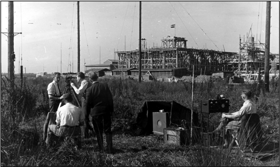
De NERA in de steigers. Op de voorgrond worden metingen verricht (1949).
