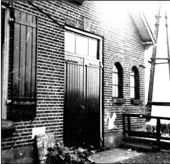
Het gemaal van de Horn- en Kuijerpolder.
