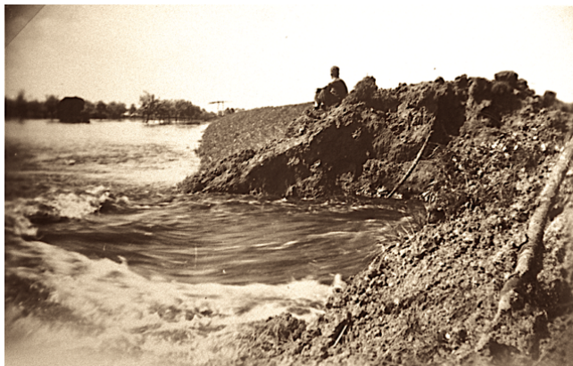
Het gat aan de zuidkant van het boezemkanaal. Op de achtergrond is even na de brug Rustoord in beeld
