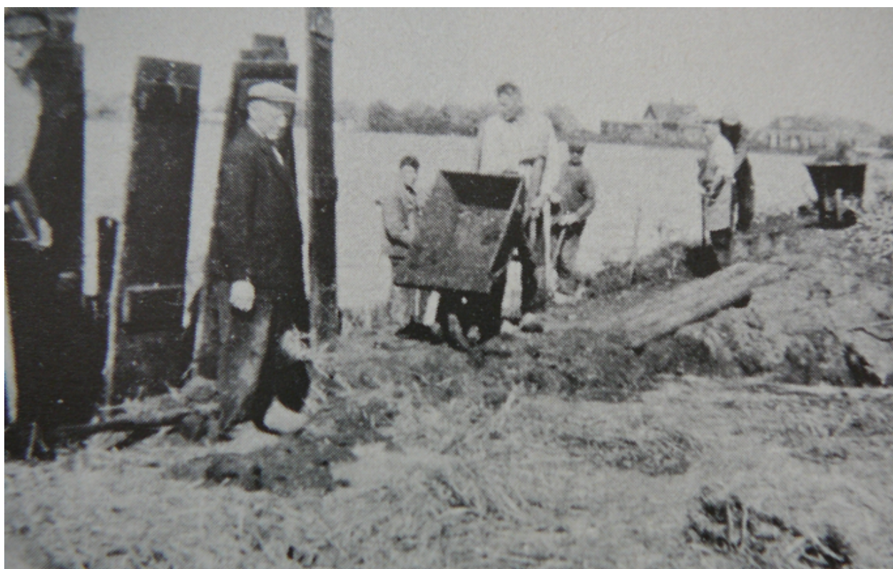
Herstel van de Horndijk met op de achtergrond de huizen aan de Overmeerseweg (1945)
