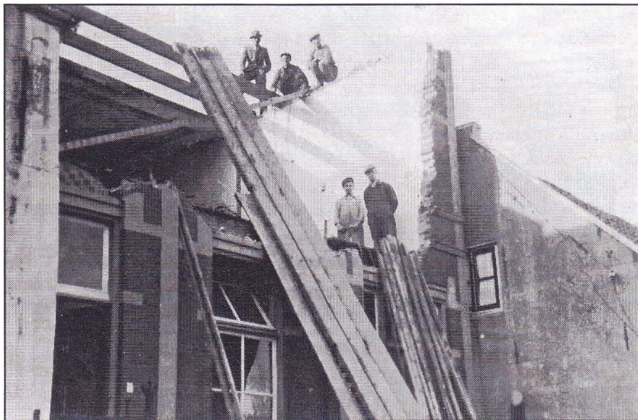
Sloop voorgevel aan de kant van Groenendaal (1936).
