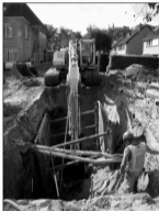
Afb. 2. Aanleggen van de bezinkput op circa 4 meter diepte. (foto auteur 14-09-09).
