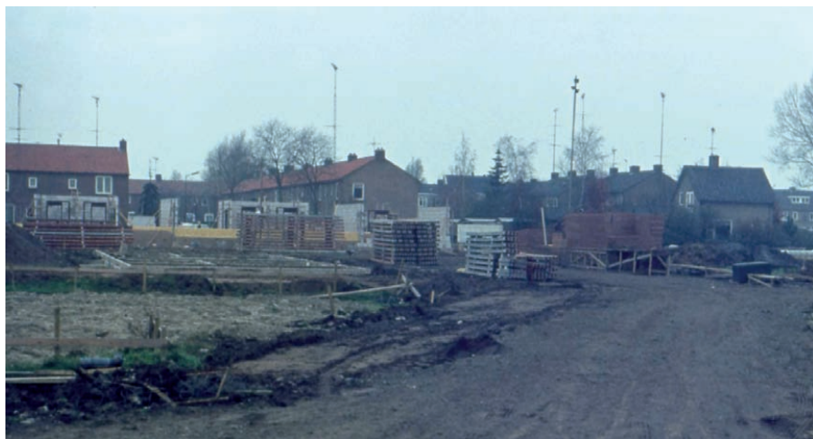
Uiterdijksehof in aanbouw, 1976. Nieuwbouw langs de Wethouder Bloklaan. Een project van sociale huurwoningen en vrije sectorwoningen.
