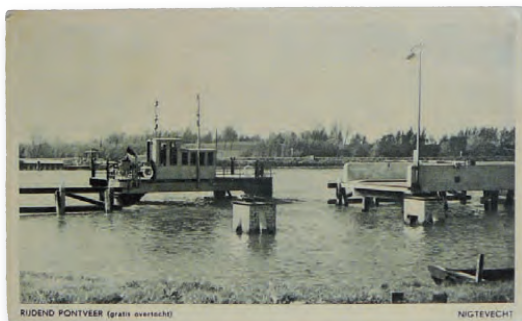
In 1948 verving de rijdende pont de draaibrug vanwege de verbreding van het kanaal. In 1967 is hij uit de vaart genomen. Ook voor Nigtevecht was toen de verbinding met Abcoude verbroken. Op de achtergrond Fort Nigtevecht.
