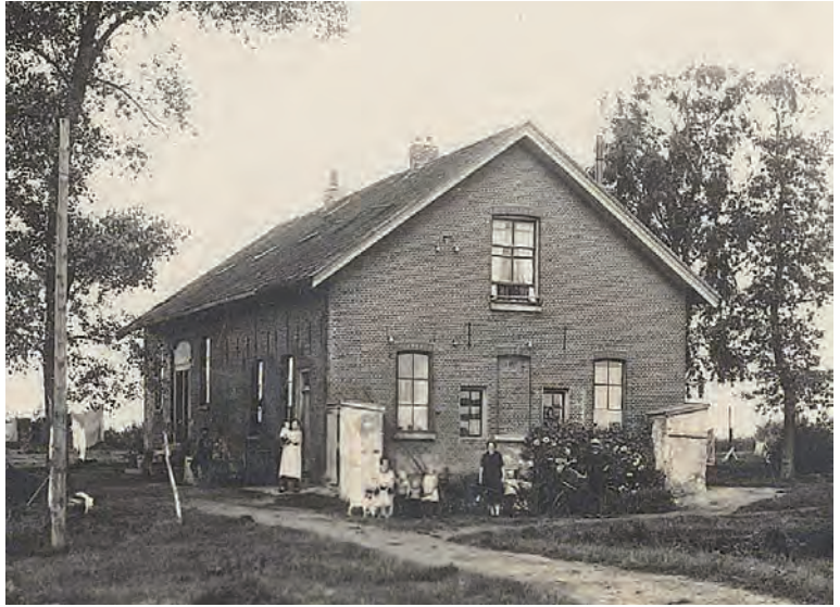
Het oude stoongemaal was omgebouwd tot woningen voor drie gezinnen. De foto is uit de jaren dertig. De twee toiletten staan nog buitenshuis.
